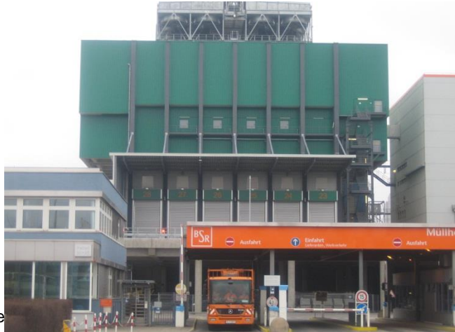
MHKW Ruhleben, Ansicht Anlieferbereich
